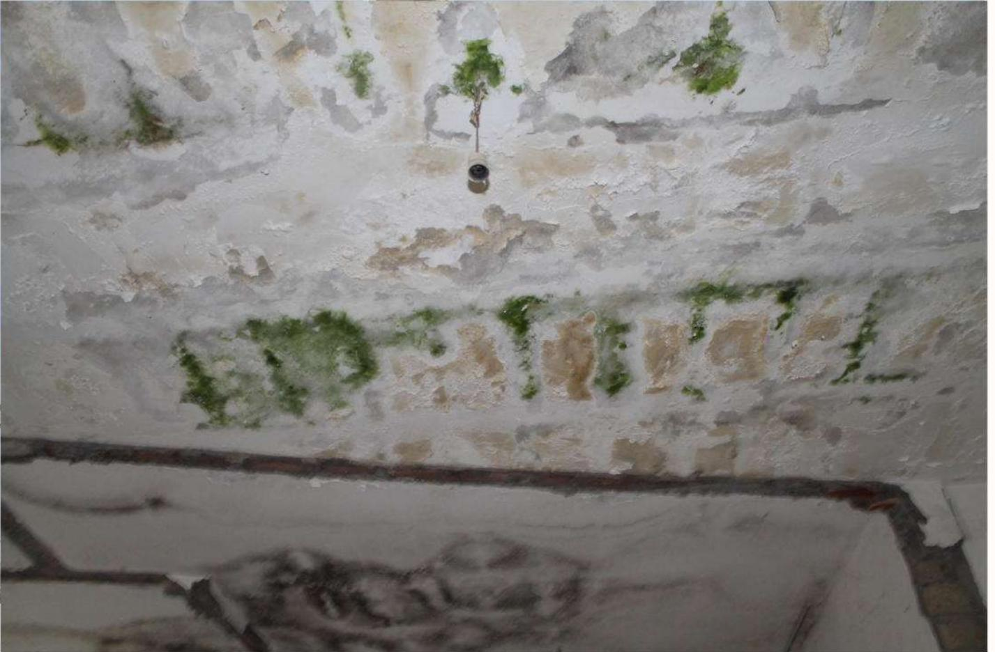
*Solaio soffitto danneggiato per infiltrazioni d'acqua*
